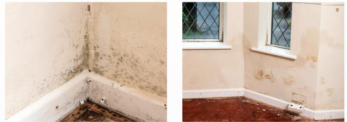
**Verstärkter Wärmeverlust** – Feuchtigkeit in porösen Baumaterialien verursacht eine Abnahme der isolierenden Eigenschaften wie, wenn Luft in den Poren durch leitfähigeres Wasser ersetzt wird. Zum Beispiel ist die thermale Leitfähigkeit von nassen Ziegeln ist doppelt so groß wie der trockener Ziegel.
