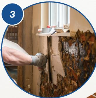
Tragen Sie eine erste Schicht auf 3 Teile Sand und 1 Teil Zement mit der oben beschriebenen, verdünnten Renderguard Gold Lösung präparieren. Tragen Sie eine erste Schicht bis zu einer Schichtdicke von 12 mm auf. Nicht übermäßig verspachteln.
