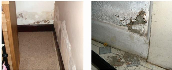
**Erosion der Bausubstanz des Gebäudes** – Salze aus dem Boden werden durch aufsteigende Feuchtigkeit in die Wand aufgesogen und können das Verbundmaterial in Ziegeln, Steinen und im Mörtel auflösen. Die Kristallisierung von Salz kann solche Kraft auswirken, dass Mikrostruktur von Mörtel, Ziegel oder Stein zerstört wird.
