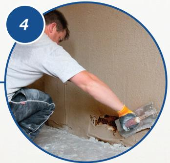
Tragen Sie eine zweite Schicht auf Vor vollständigem Trocknen der ersten Schicht eine zweite Schicht mit 12 mm Dicke, bei freier Auswahl eines geeigneten zweiten Putzes, auftragen.
