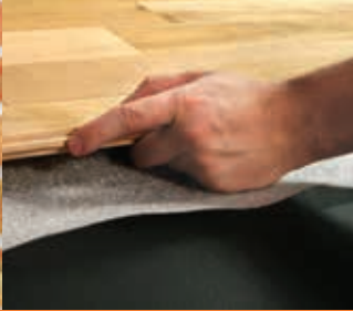
Holzbohlen über Drybase
