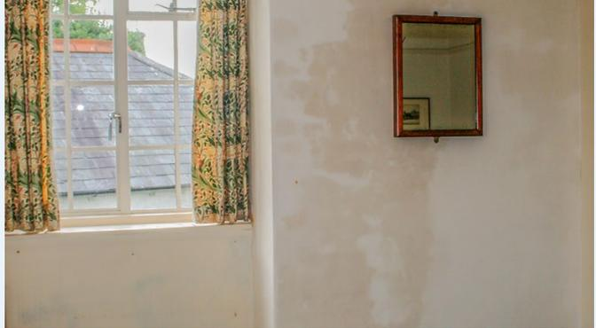
**Hygroscopische Feuchtigkeit** – In diesem Fall wurde es nicht durch aufsteigende Feuchtigkeit verursacht, sondern durch hygroscopische Salze in einem Kamin, die durch das Verbrennen von Kohle entstanden waren.
