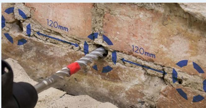
Bohren Sie Löcher in 120 mm Abständen
