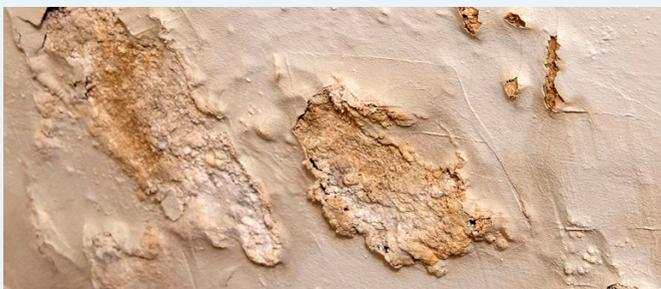
**Kontaminierung hygroskopischer Salze** – Putz mit schwerer Salzkontaminierung muss immer ersetzt werden - unabhängig davon, welches System gegen Feuchtigkeit eingesetzt wird.
